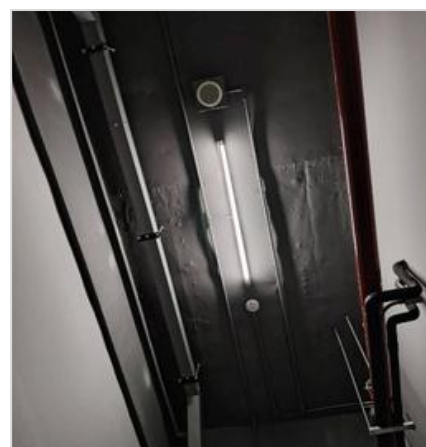
หลอด LED Motion Sensor ในหลอดไฟส่องสว่าง สำหรับตรวจจับความเคลื่อนไหวทางเดิน
